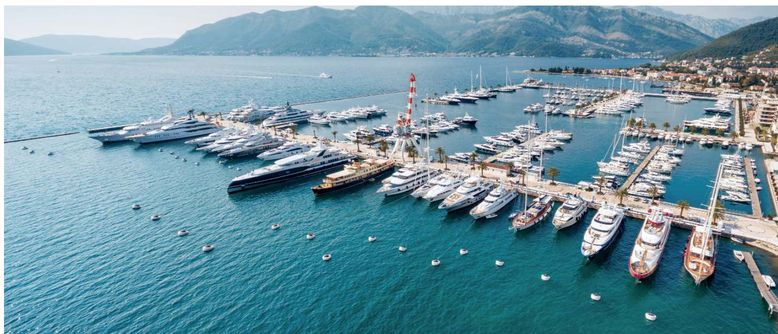
Porto Montenegro realizzato con frangionde, moli e pontili galleggianti
