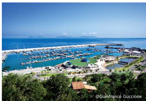
Strutture galleggianti Ingemar al Marina Capo d'Orlando
