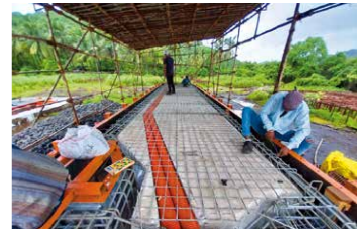
Costruzione in sito a Umarsadi in India
